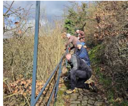
Das Geländer am Zugangsweg wird gestrichen
